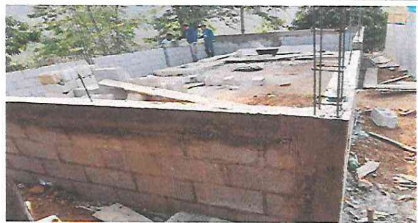
Foto 2: se observa que ya se inicio la reparacion del edificio escolar para mejor y mantener los modulos
