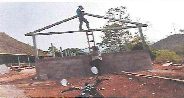
Foto 3: aquí se ve que ya se esta avanzando la reparacion de las ualas y hacer un mantenimiento del edificio escolar
