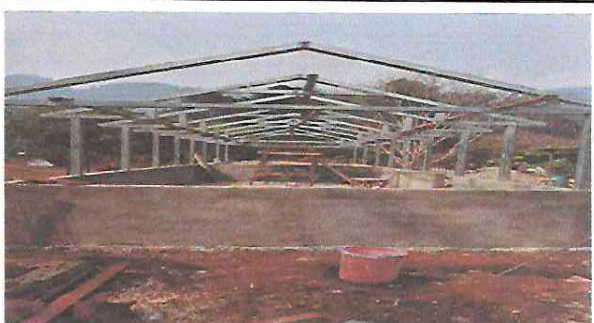
Foto 4: se observa que ya esta instaladas las estructuras metalicas, como los tubos de 4x4 para el entechado de las laminas
