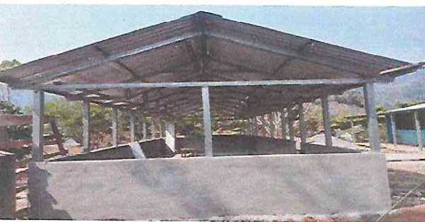
Foto 5: se observa que ya se ha instaladas las costaneeras como instalacion de laminas, se ve que ya esta estructuradas todas instalaciones
